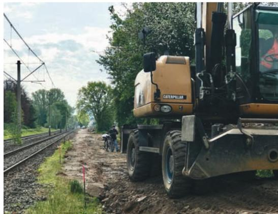
*Grundsolide: Bau eines drei Meter breiten Radwegs mit Frostschutz-Unterbau und Asphaltdecke parallel zur Stadtbahntrasse*
